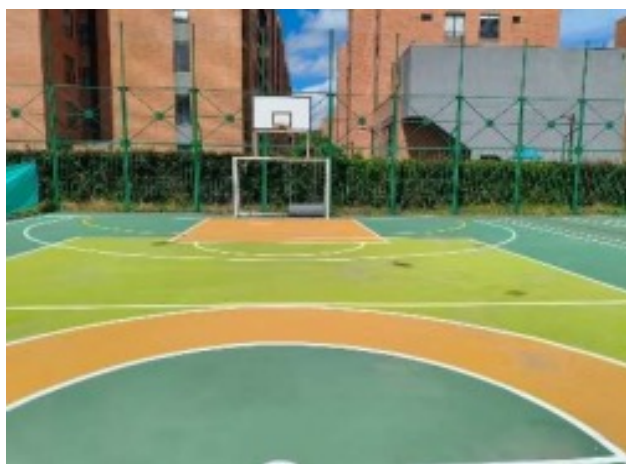
Ilustración 51 Trabajos Terminados Escenarios Deportivos
